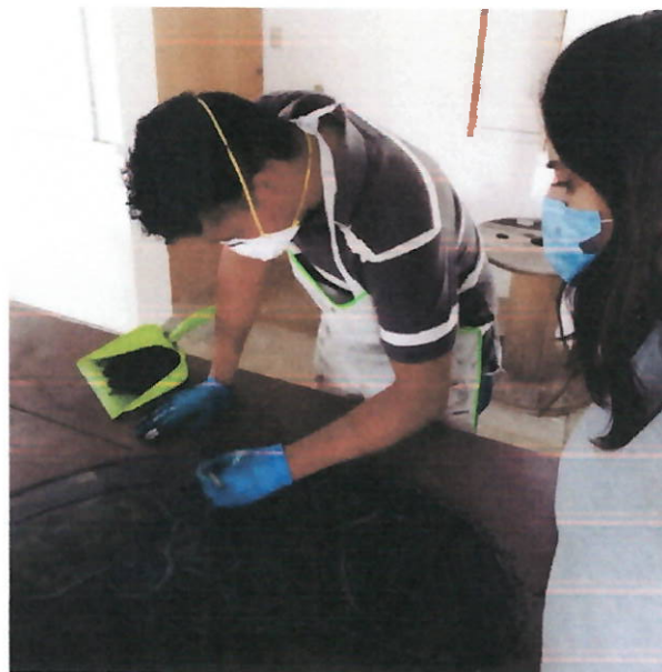
SUPERVISIÓN DE LA LIMPIEZA DEL ENMACILLADO
